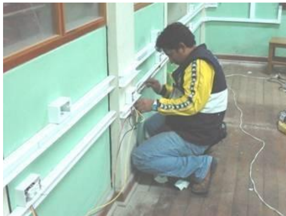
Figura 15 Demostración de colocación de canaletas Fuente: (Raffino, 2020)
